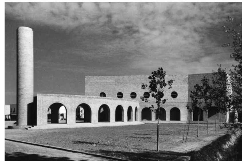
Sotto: Borgo rurale, Vigonza, il teatro, prospetto nord, e il loggiato destinato originariamente a mercato coperto.
