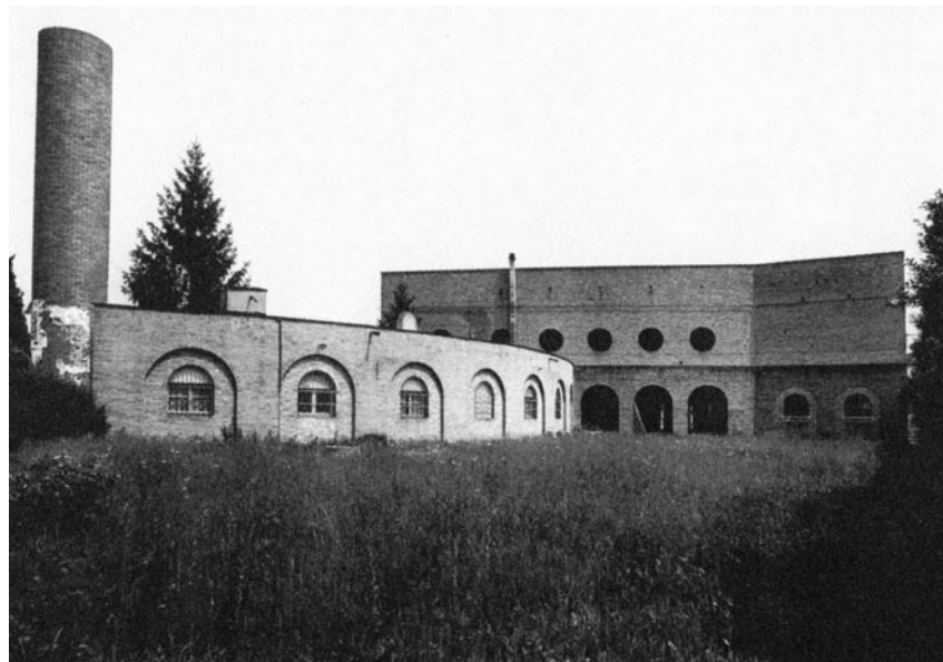
Teatro del Borgo rurale, Vigonza, loggiato originariamente destinato a mercato coperto con le arcate tamponate.
