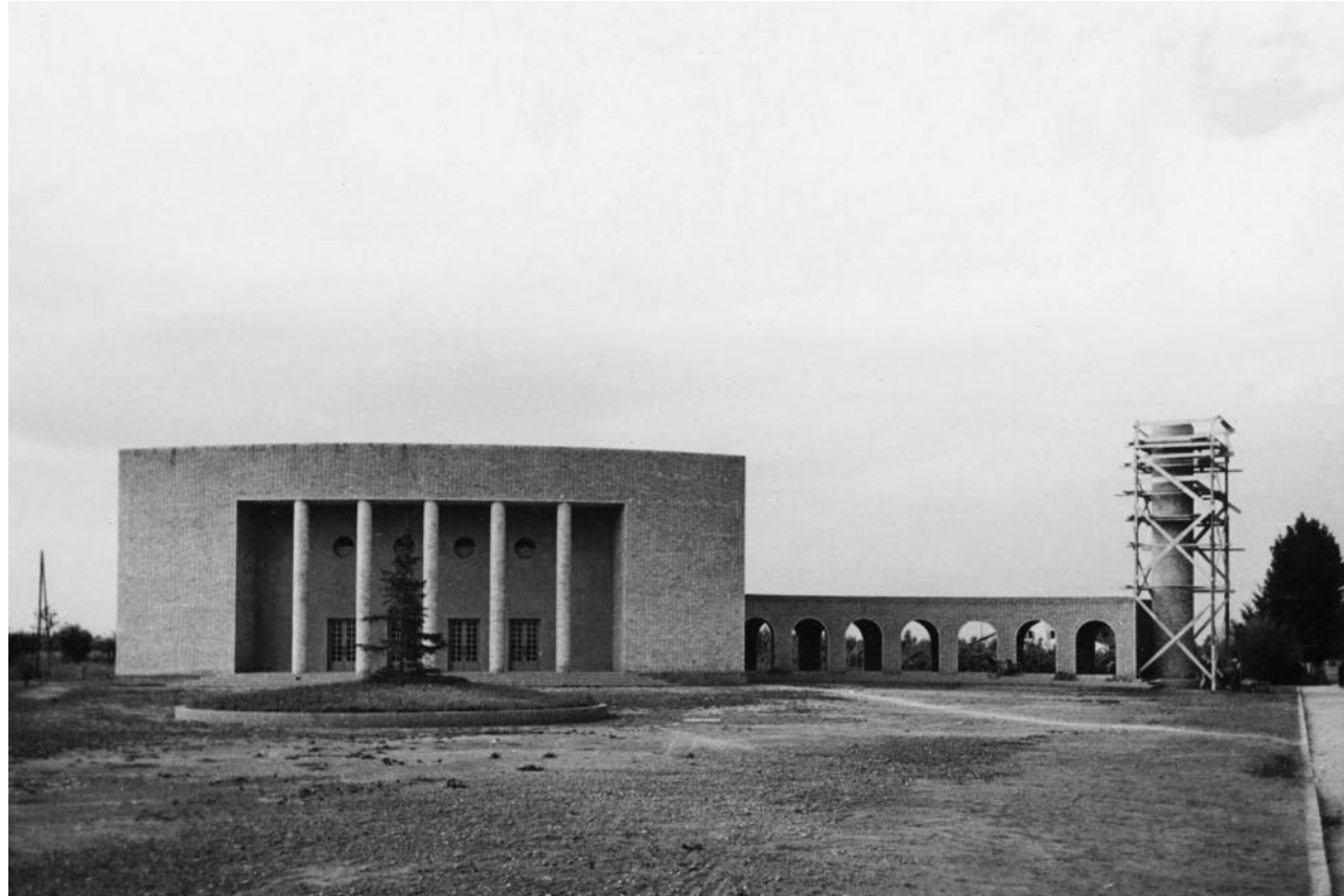
Teatro del Borgo rurale, Vigonza, foto di cantiere. 1938-39.
