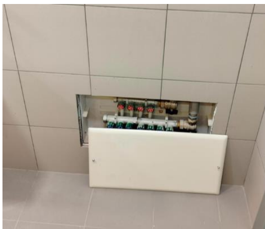
Figura 39 - Chiusura dello sportello frontale dei collettori
