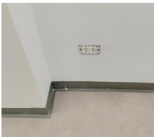
Figura 29 – Applicazione di mascherina presa elettrica
