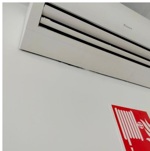
Figura 22 - Sigillatura sotto split
