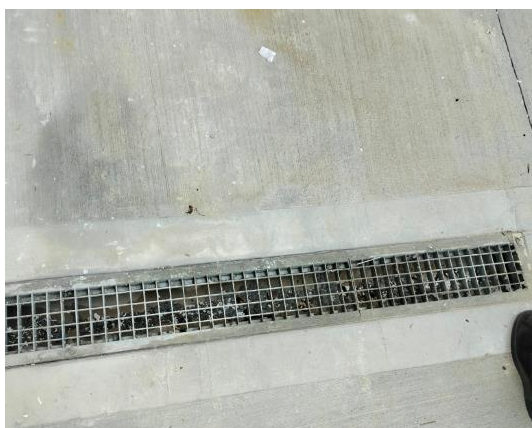
Figura 3 - Pulizia della caditoia su rampa cortile
