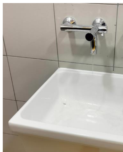
Figura 30 - Verifica del corretto funzionamento dei rubinetti bagno femmine piano terra e messa in bolla
