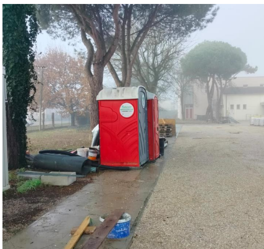
Figura 1 – Pulizia del cantiere con rimozione di baracche e WC chimico
