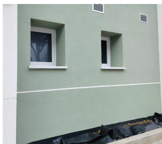
Figura 6 - Intonacatura della bisellatura del cappotto
