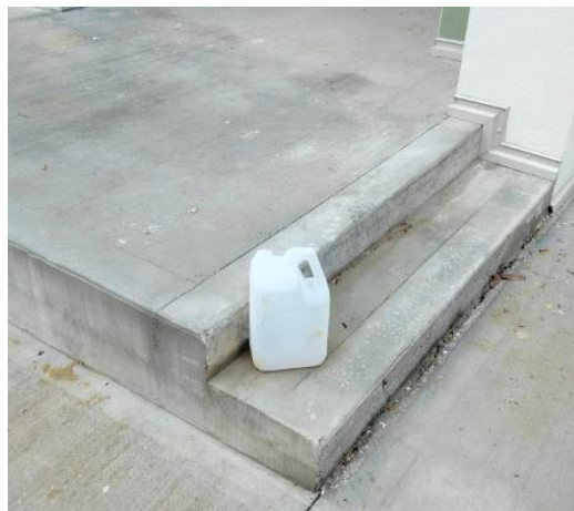
Figura 18 - Ripristino superficiale gradini della rampa lato est
