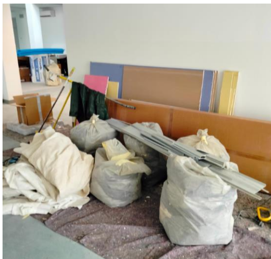
Figura 19 - Pulizia area interna
