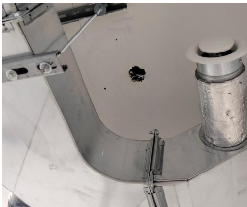
Figura 37 - Ripristino fori presenti nel locale Ripostiglio al piano primo
