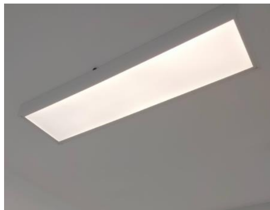
Figura 38 - Stuccatura e tinteggiatura fori a soffitto
