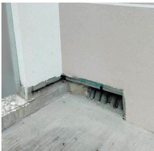
Figura 9 - Realizzazione del cappotto a copertura delle tubazioni sul fronte nord
