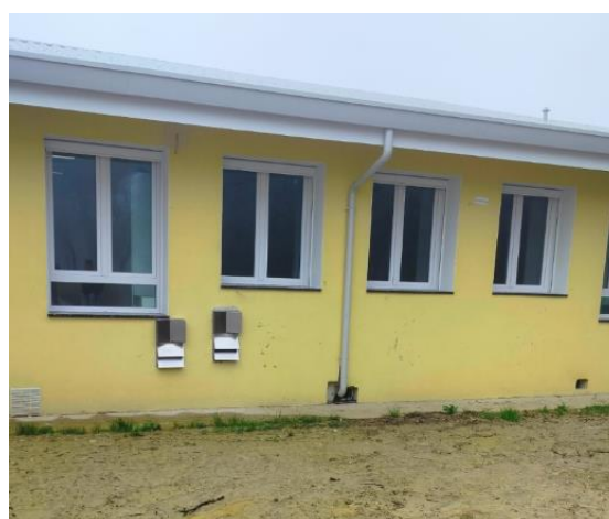
Figura 12 - Apposizione delle griglie di protezione sul cappotto
