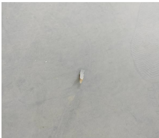
Figura 25 – Sistemazione pavimento in PVC
