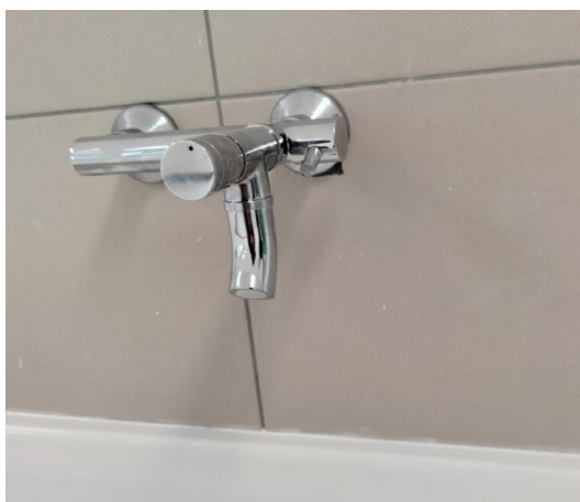
Figura 31 - Ripristino del rivestimento
