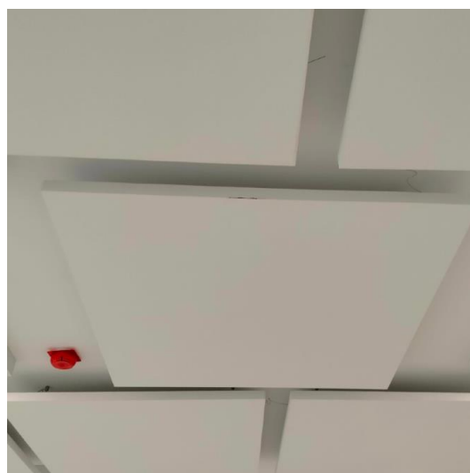
Figura 36 – Ripristino pannelli fonoassorbenti a soffitto
