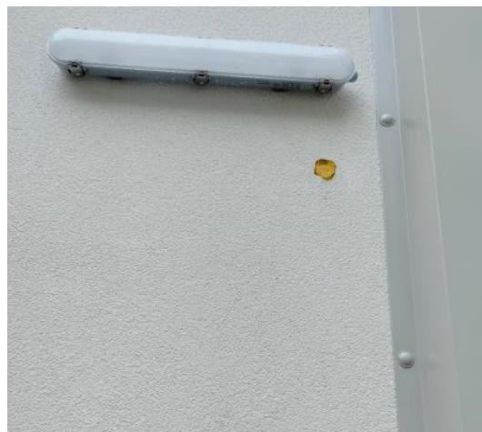
Figura 8 - Sistemazione cappotto fronte sud zona ingresso
