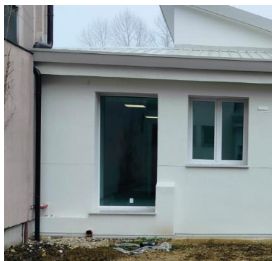
Figura 14 – Collegamento pluviale al pozzetto di raccolta
