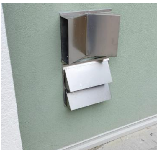
Figura 13 - Esecuzione delle protezioni degli spigoli delle aerazioni
