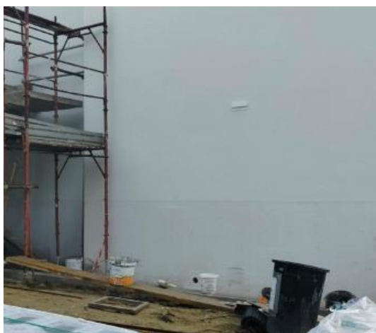
Figura 5 - Completamento intonachino cappotto
